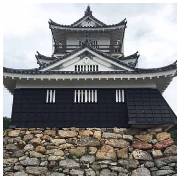
写真右下には石落としが見える。▲
